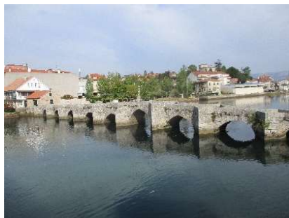
San Pedro - ponte medievale sul Rio Miño
