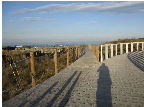
Passerelle dopo Marinhás
